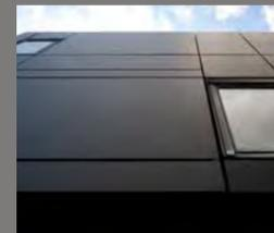
Der optionale um 4cm tiefere und damit mit der Bedachung bündige Einbau sorgt für eine noch harmonischere Integration.
